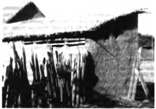
14.6-2 Традиционная грунтовая кровля, север Венесуэлы
