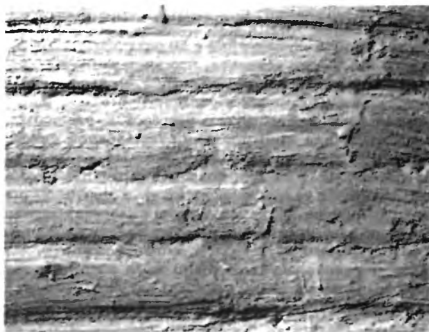
8.4-14 Глиноизвестковая побелка стены из глиносырцовых изделий
