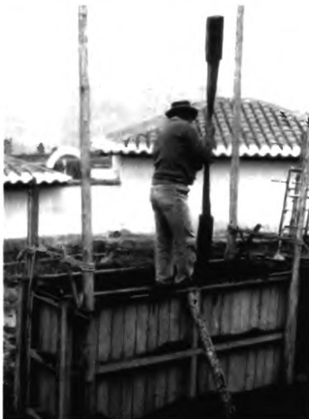
5.3-2 Двухсторонняя ручная трамбовка, Эквадор
