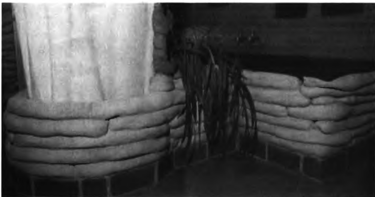
14.10-4 Обкладка санитарных приборов глинобетонными изделиями в хлопчатобумажной оболочке, ванная комната жилого дома в Касселе, Германия
