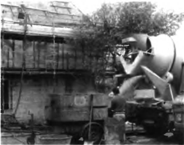
10.5-12 Доставка и перекачивание бетононасосом глинобетонной смеси
