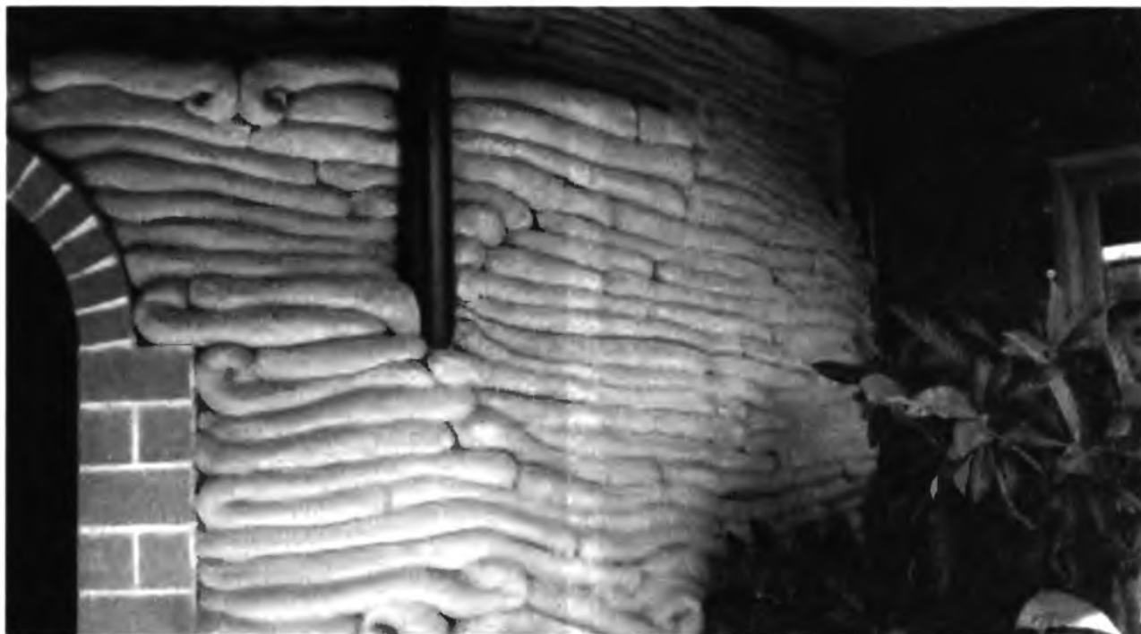
10.8-8 Внутренняя стена зимнего сада из глиносырцовых изделий в хлопчатобумажной оболочке, служащая для аккумуляции тепла и регулирования влажности в помещении
