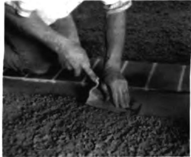
14.4-8, 14.4-9 Устройство грунтового пола с покрытием гидрофобным составом
