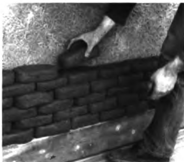
14.8-2 Укладка пластичного глинобетона
