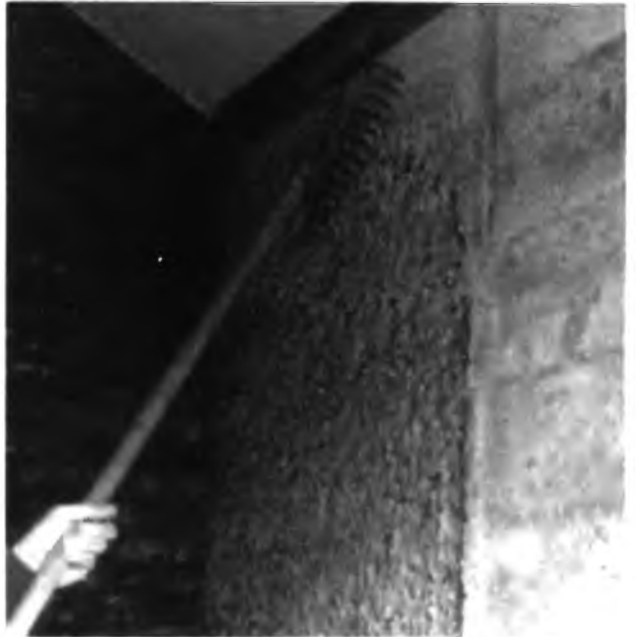
10.5-14 Обработка поверхности стены из глинокерамзитобетона граблями
