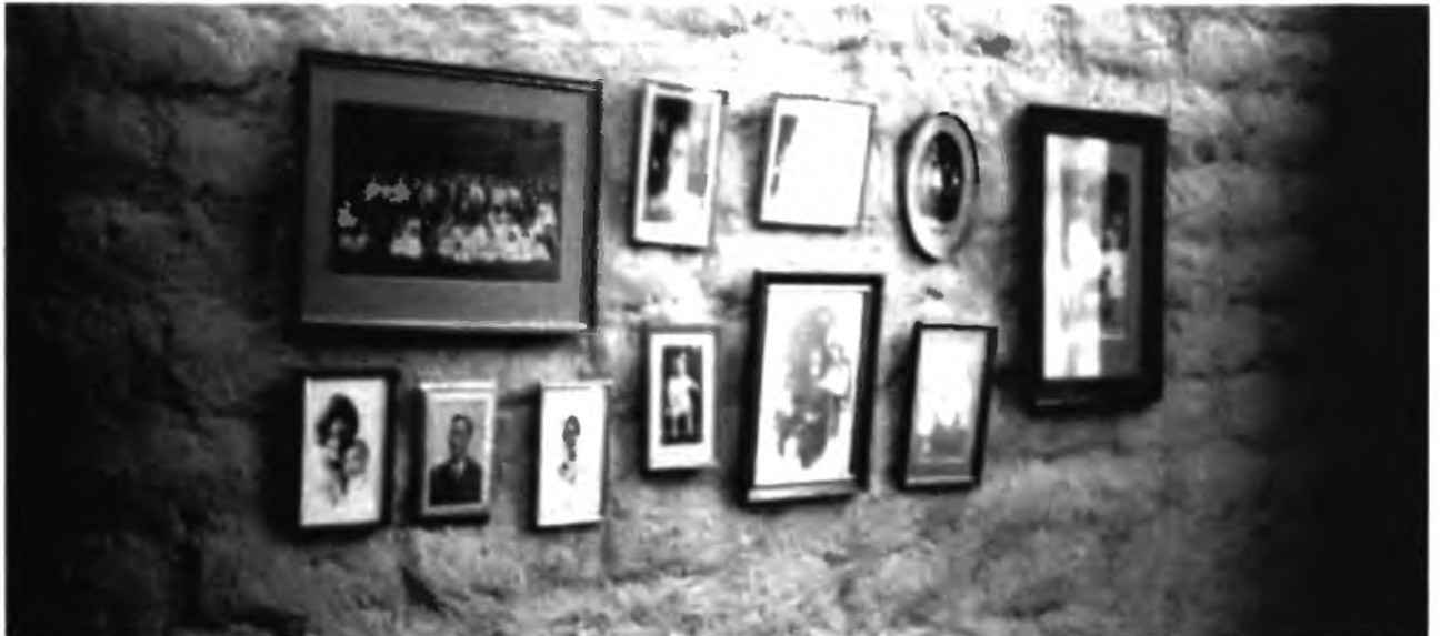
6.6-1 Стена из необожженного кирпича, покрытая известково-глиняным молоком. Жилой дом в Бендиго, Австралия
