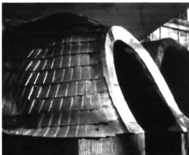
12.6-5 Глинобетонный купол, покрытый пластинами для офсетной печати (ФЕВ).
