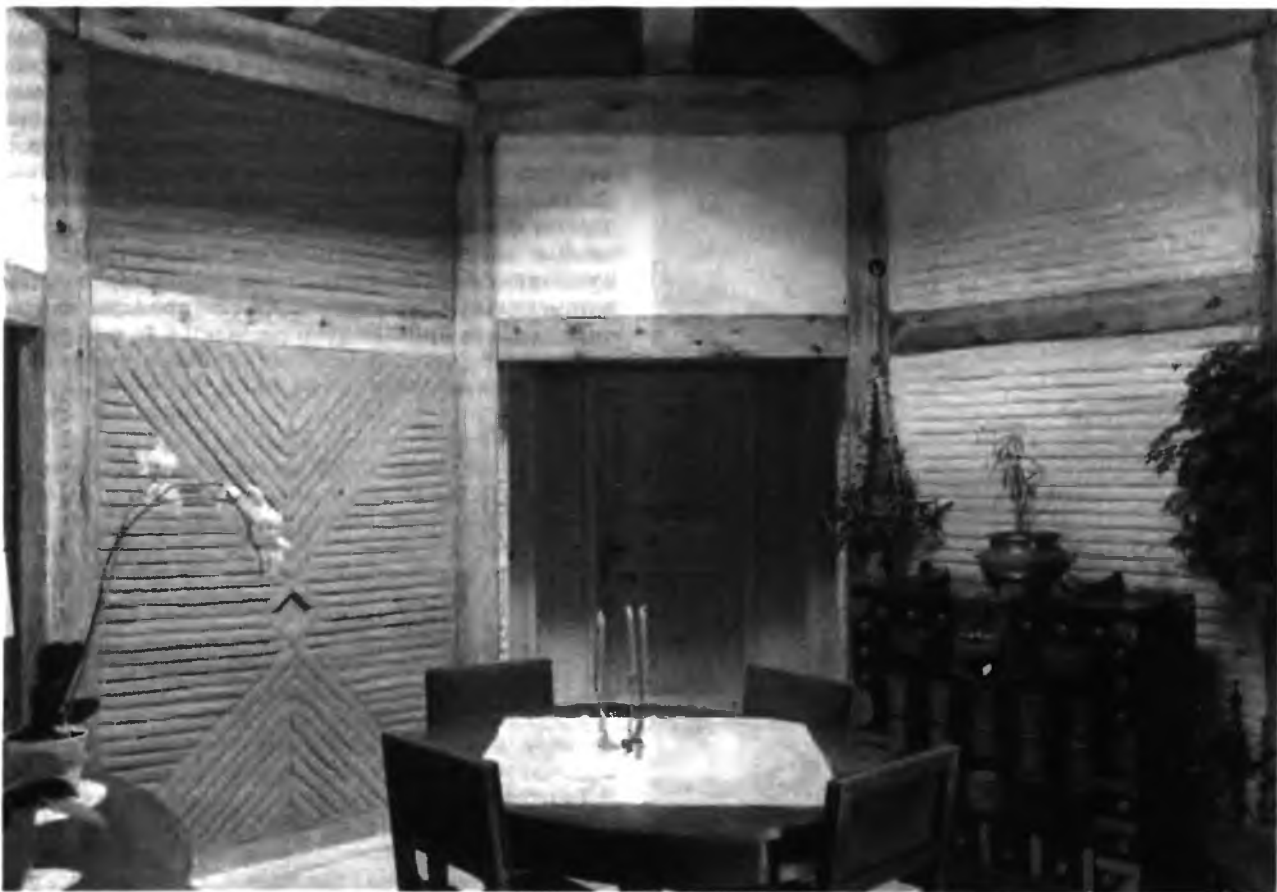
8.4-19 Законченная перегородка из сырцовых блоков, Германия, 1986 г.
