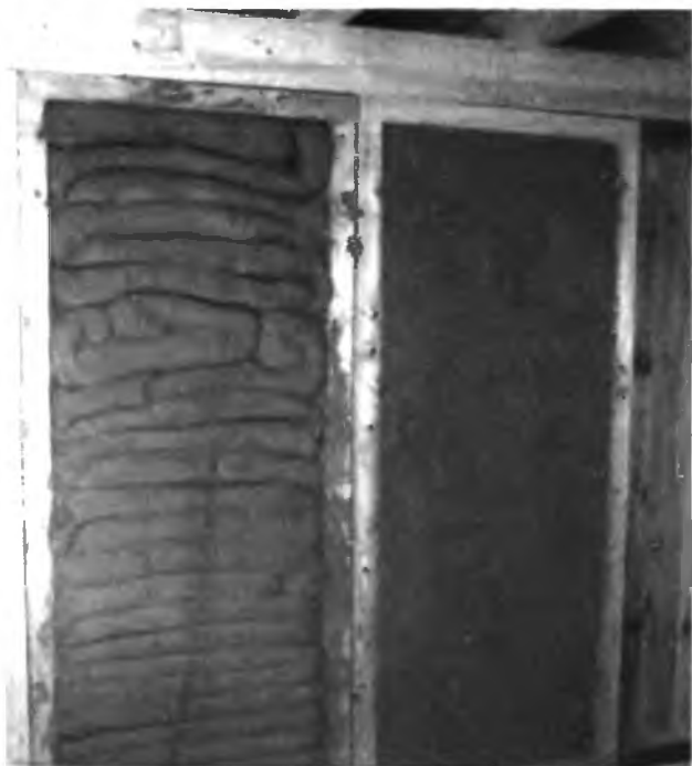
7.3-3 Панели для каркасных домов с заполнением из легкого глинобетона.
