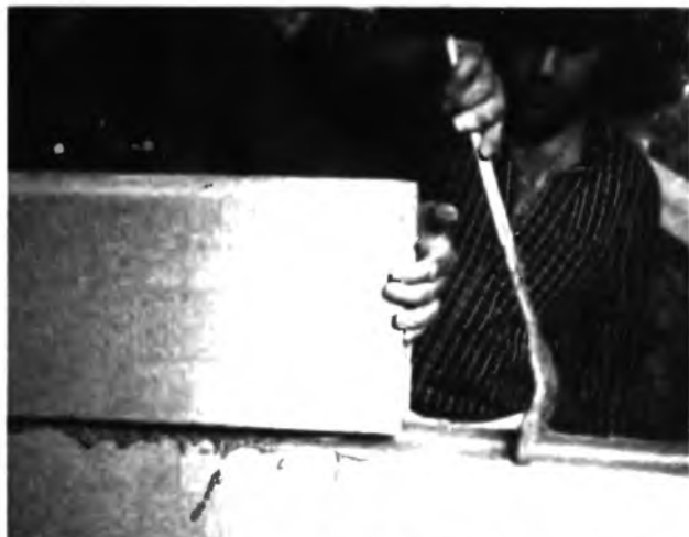
7.3-1 Внутренняя стена из легких глинобетонных плит
