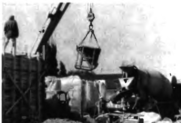
10.5-7 Доставка и транспортировка в опалубку глинобетонной смеси
