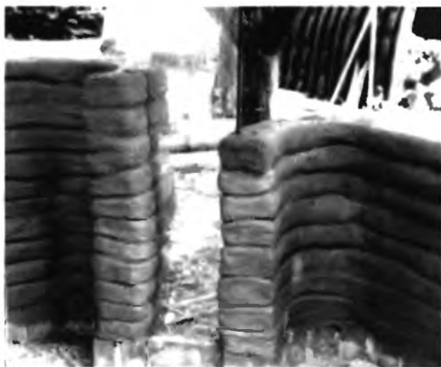
8.4-3, 8.4-4 Стены из глиносырцовых изделий, экспериментальное здание, Кассельский университет, 1982 г.
