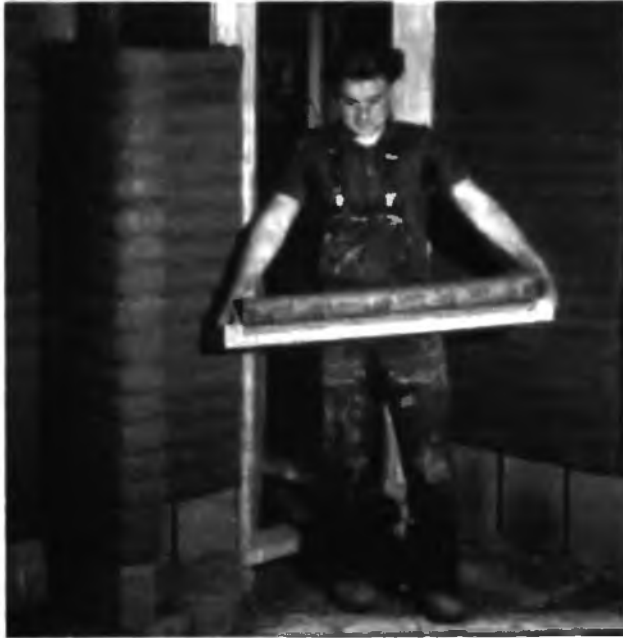
8.4-6, 8.4-7, 8.4-8 Укладка глиносырцовых изделий
