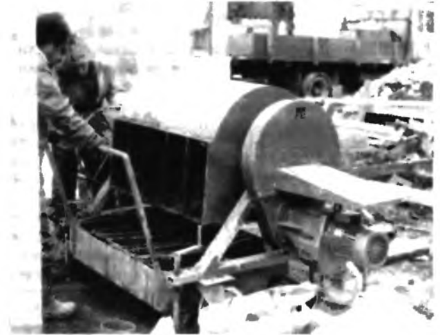
10.5-3 Приготовление глинокерамзитобетонной смеси
