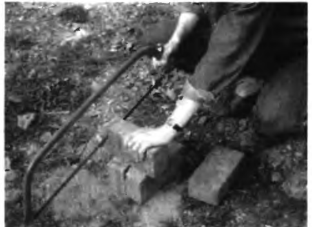
6.5-1 Распиловка сырцовых кирпичей с помощью пилы
