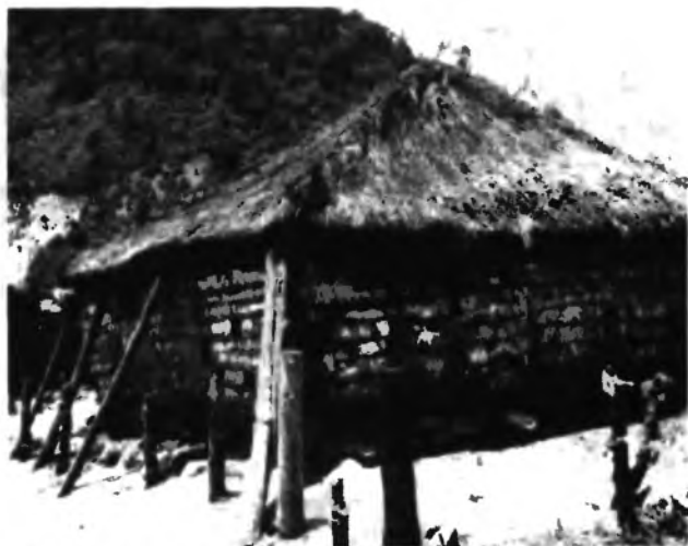
14.13-4 Дом с глиноплетневыми стенами после сильного землетрясения, Гватемала
