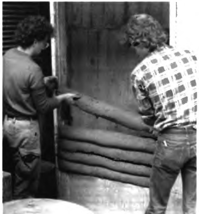
9.4-3 – 9.4-5 Современные способы изготовления вальков
