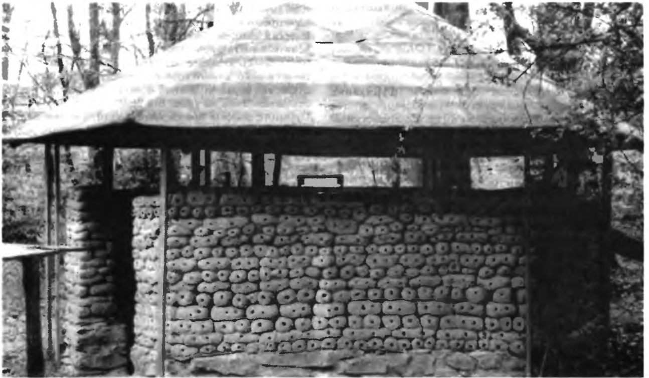
8.3-2 Нештукатуренная стена овчарни, Дюн, Германия
