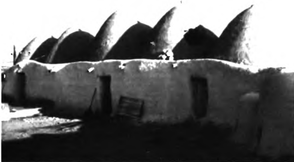
14.7-1 Купольные покрытия из грунтового кирпича, деревня недалеко от г. Алеппо, Сирия
