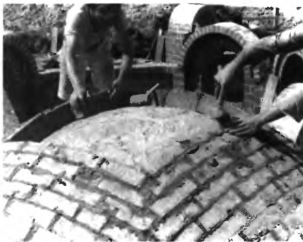
14.7-43 Возведение купола при помощи опалубки с дополнительной палубой из влажного песка
