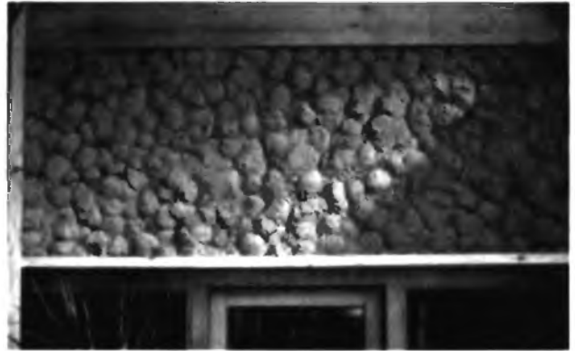
11.7-1 и 11.7-2 Африканская штукатурка, служащая для регулирования влажности и аккумуляции тепла в зимнем саду
