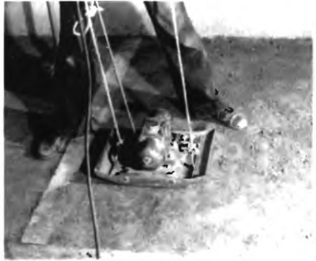
14.4-3 — 14.4-5 Устройство грунтового пола
