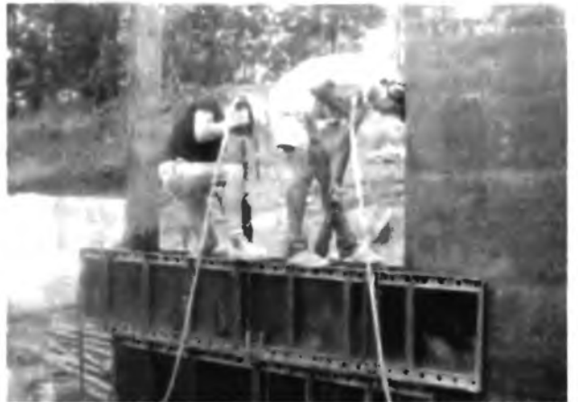
5.6-6, 5.6-7 Возведение стен из монолитного глинобетона, фирма «Террастоне»
