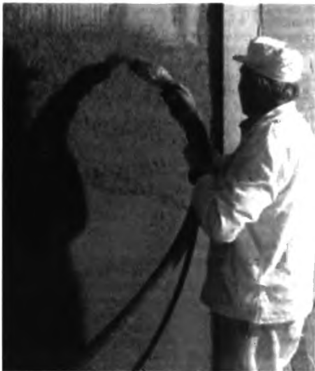
11.5-1 Нанесение легкого глиняного штукатурного раствора механизированным способом
