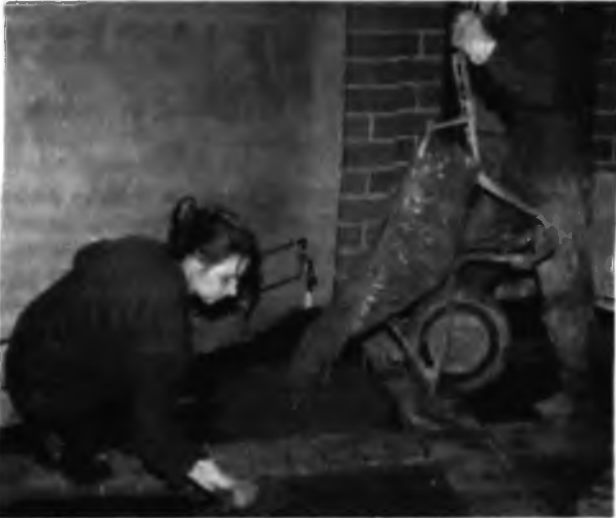
14.4-8, 14.4-9 Устройство грунтового пола с покрытием гидрофобным составом
