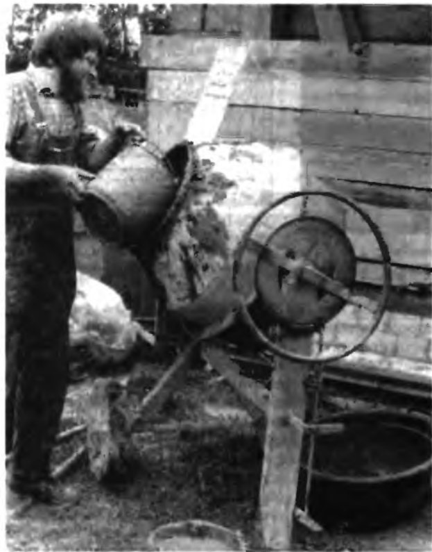
10.5-6 Приготовление глинокерамзитобетонной смеси в бетономешалке
