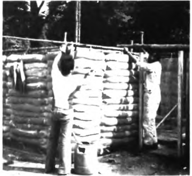
14.13-18, 14.13-19 Стена из глинобетонных изделий в джутовой оболочке, ФЕВ, 1978 г.
