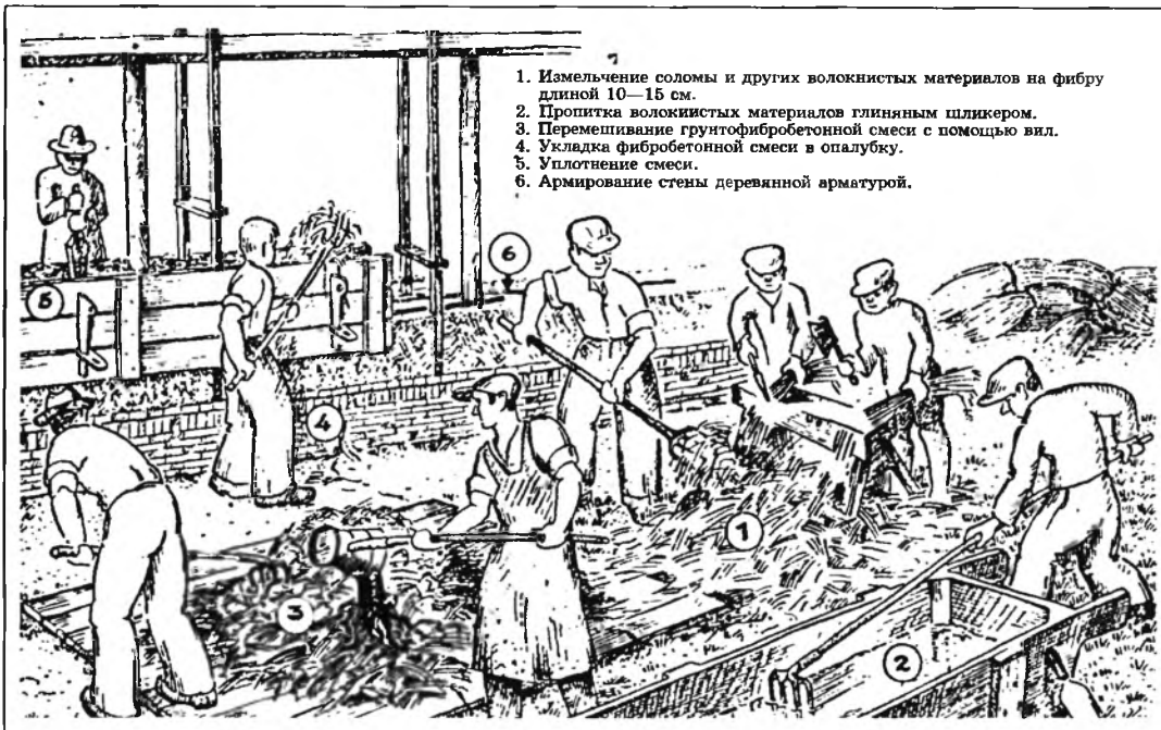
10.3-1 Организация рабочего места и труда глиобетонщиков, Фаут, 1948 г.
