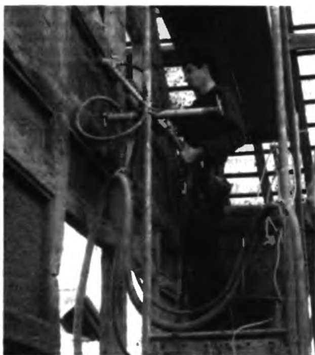
9.3-1 Механизированное нанесение легкой глинобетонной смеси
