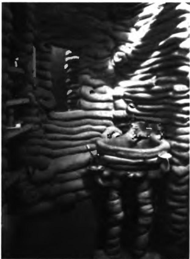
14.10-3 Встроенные в глинобетонную стену полки, зеркало, лампа
