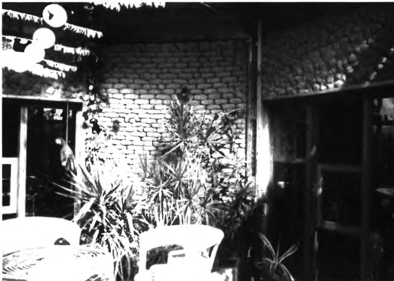
14.8-1 Стена зимнего сада, аккумулирующая тепло
