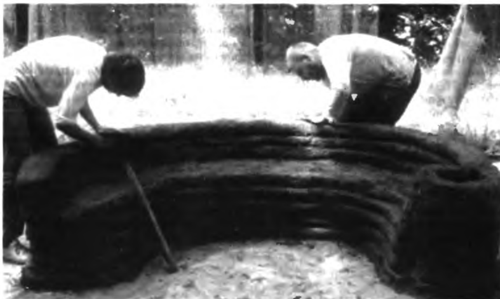
8.1-1 Изготовление скамьи из глинистого грунта
