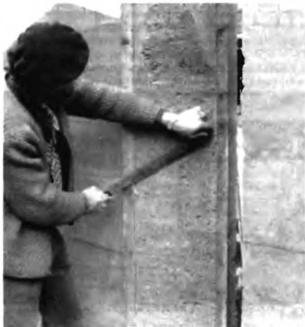
5.5-1 Обработка поверхности монолитного глинобетона после разопалубки
