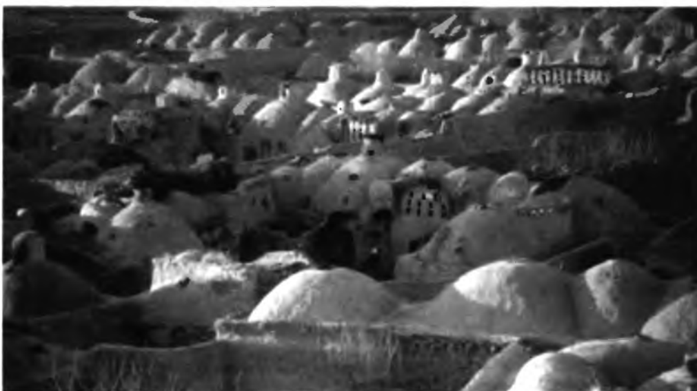
14.7-2 Купольные покрытия из грунтового кирпича, Сьестан, Афганистан
