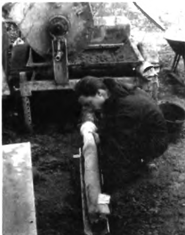
10.8-1 Заполнение хлопчатобумажной оболочки легкой глинобетонной смесью при помощи винтового насоса
