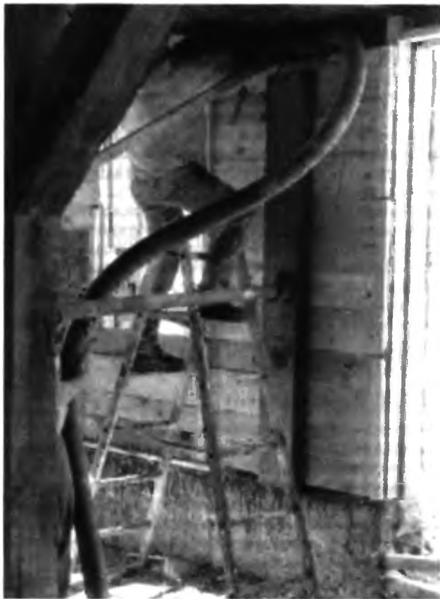
13.6-1 Перекачивание легкого глинобетона на минеральном заполнителе
