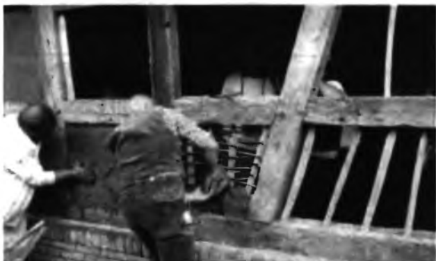
9.2-3 Варианты нанесения глинобетонной смеси, 1979 г.
