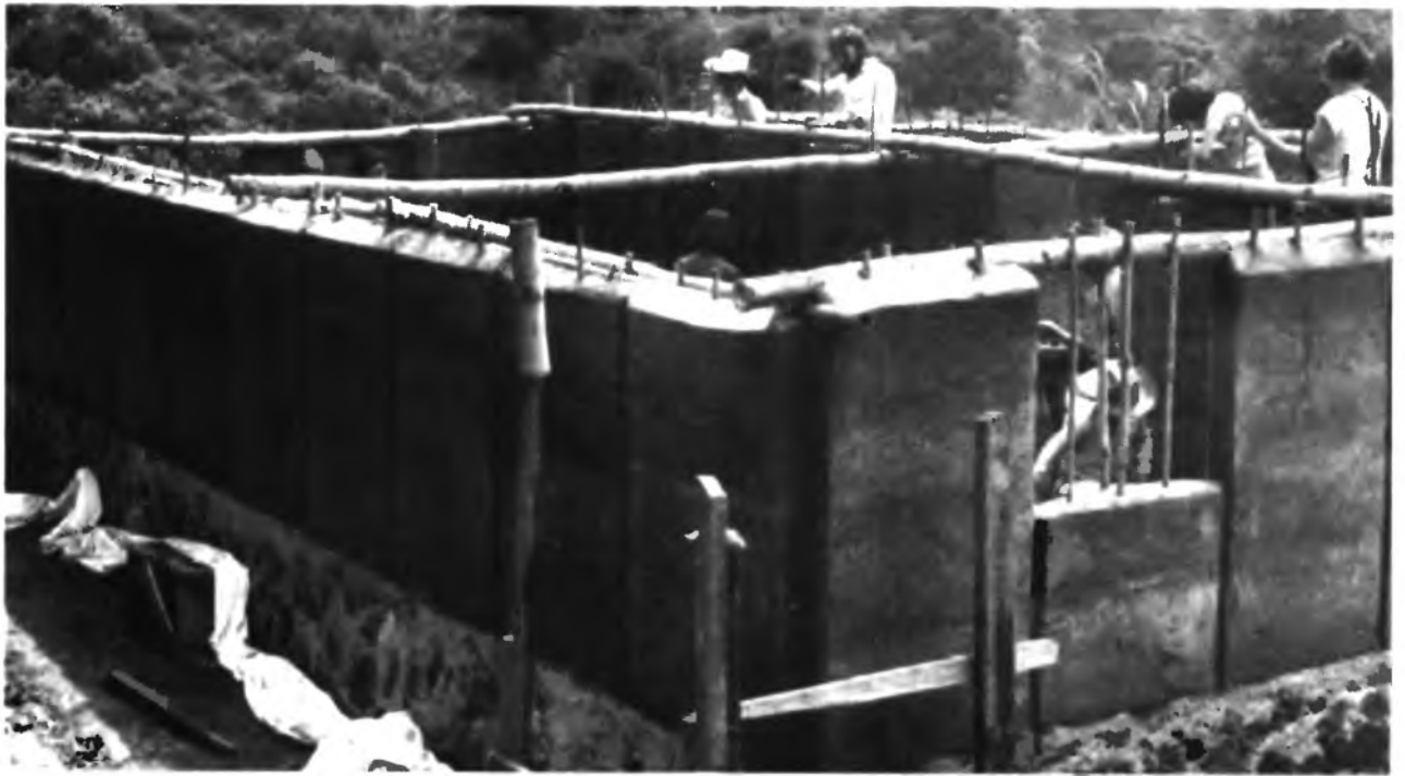
14.13-9—14.13-13 Здание, устойчивое к землетрясениям, с монолитными глинобетонными стенами, армированными бамбуком, Гватемала, 1978 г.
