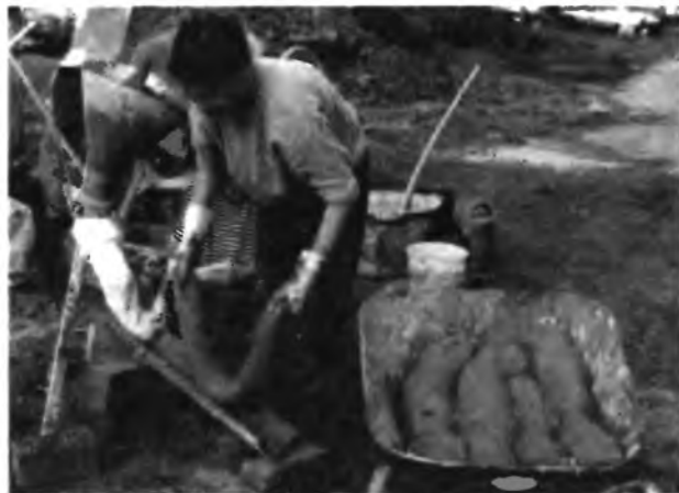
10.8-2, 10.8-3 Заполнение хлопчатобумажной оболочки легкой глинобетонной смесью при помощи воронки
