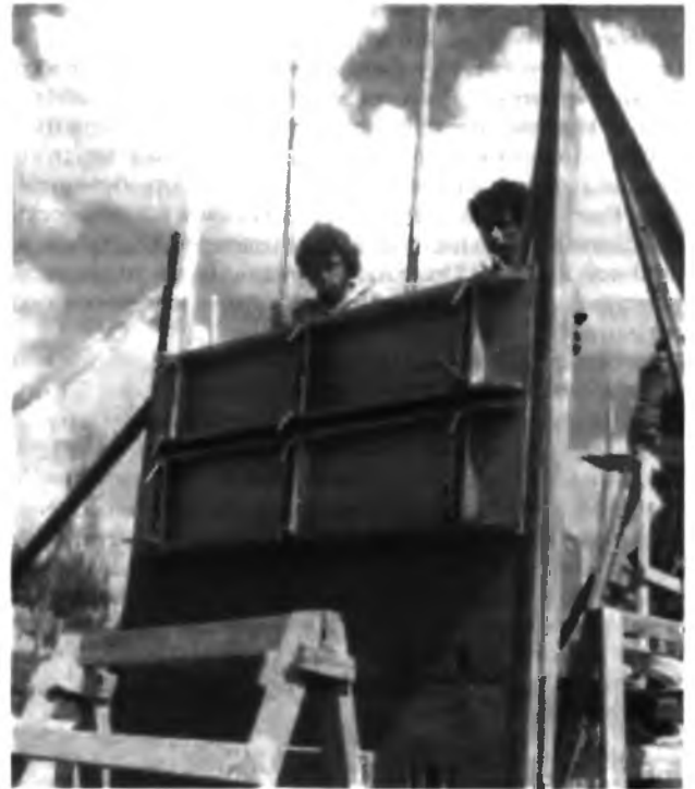
5.6-12 Возведение цементогрунтовых стен каркасных домов, СЕРЕД, Бразилия
