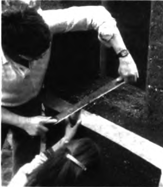
10.5-2 Устройство оконных проемов при помощи мачете
