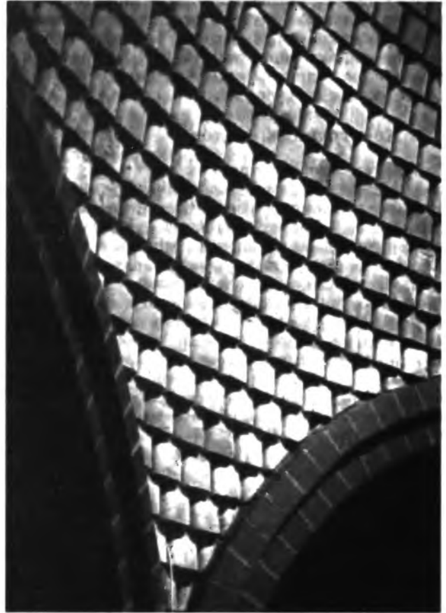
7.5-1 Фрагмент сводчатого перекрытия из кирпича оригинальной формы
