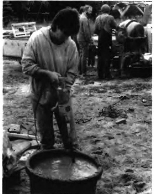
10.5-5 Приготовление глиняного раствора при помощи электрического инструмента с насадкой
