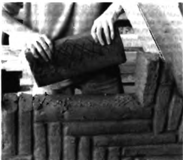
8.4-17, 8.4-18 Кладка перегородок из сырцовых блоков
