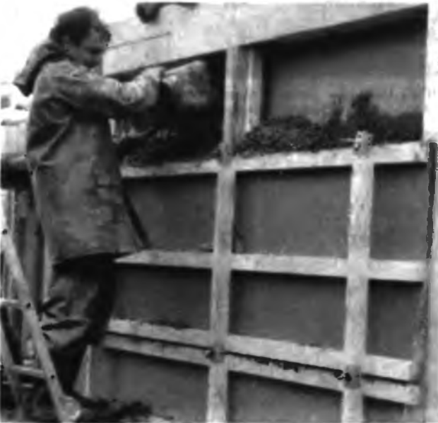
10.5-4 Укладка глинокерамзитобетонной смеси в опалубку
