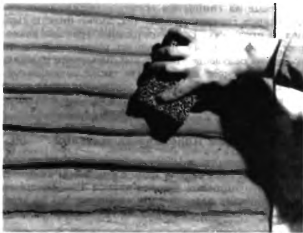
8.4-9 Обработка поверхности влажной губкой
