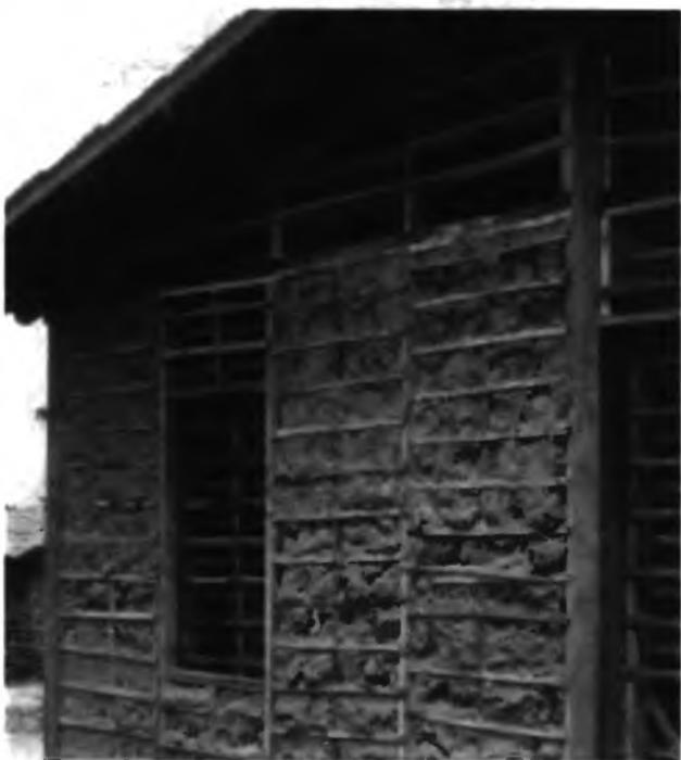
9.2-4 Предварительная подготовка к нанесению, Бразилия
