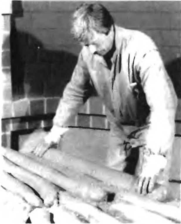
10.8-4 по 10.8-6 Кладка перегородок в ванной комнате из глиносырцовых изделий в хлопчатобумажной оболочке
