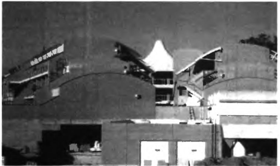
5.6-10, 5.6-11 Отель со стенами из монолитного глинобетона, Австралия
