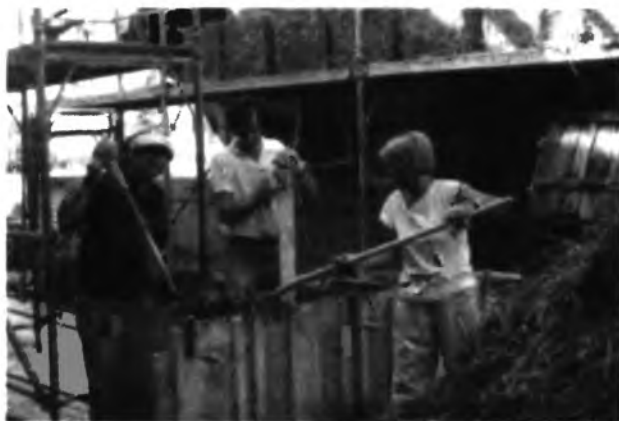
7.2-5 Изготовление саманных блоков
