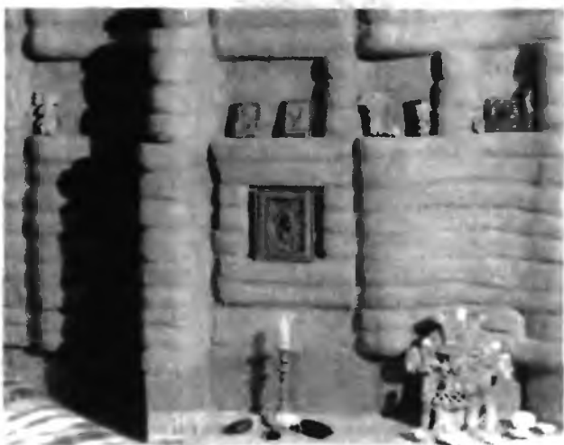
8.4-10 Законченная внутренняя стена из глиносырцовых изделий
