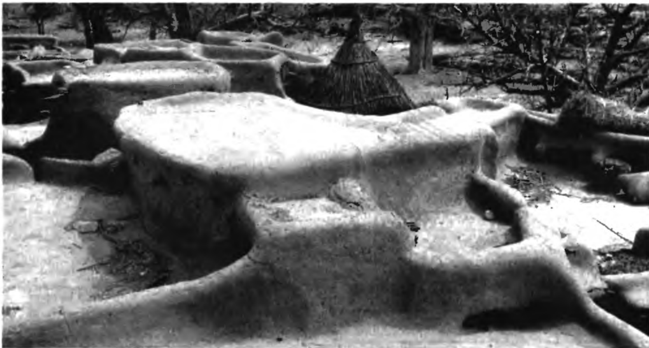
14.6-1 Грунтовая кровля по односкатной крыше в деревне племени догон, Шанга, Мали
