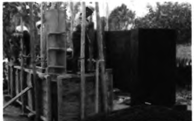
10.5-1 Возведение стены из глинопемзобетона, Паждили, Эквадор
