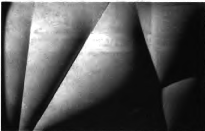
10.5-9, 10.5-10 Фрагменты внутренних стен с применением несъемной текстильной опалубки
