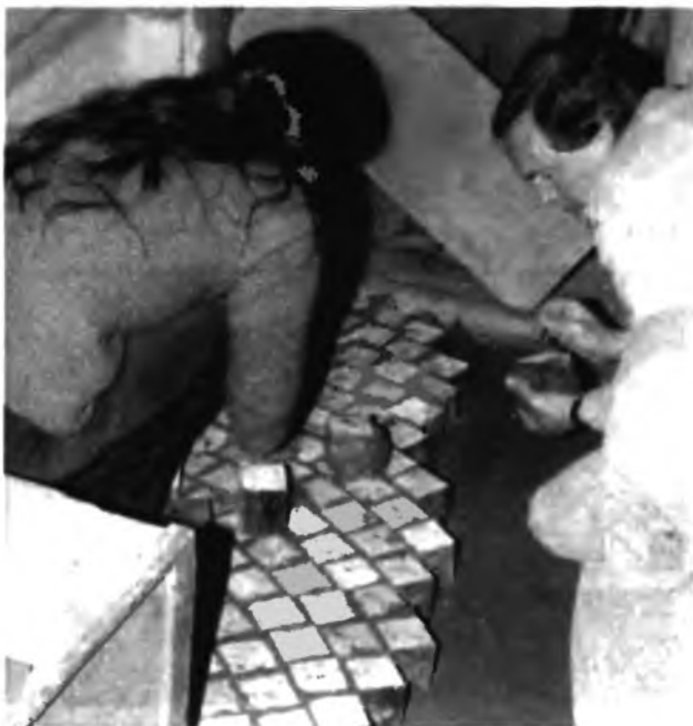
14.4-6 Покрытие грунтового пола деревянной брусчаткой
