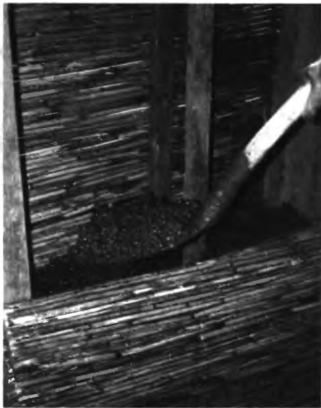
10.5-8 Транспортировка глинобетонной смеси в несъемную опалубку
