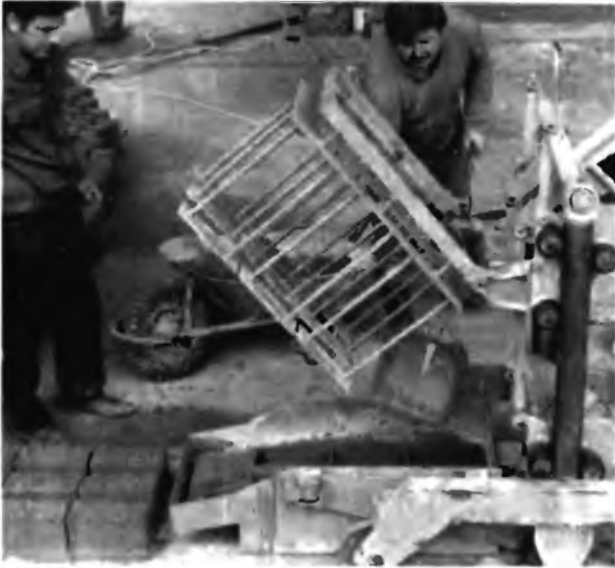
7.2-7 Изготовление глинокерамзитовых блоков, Тата, Венгрия
