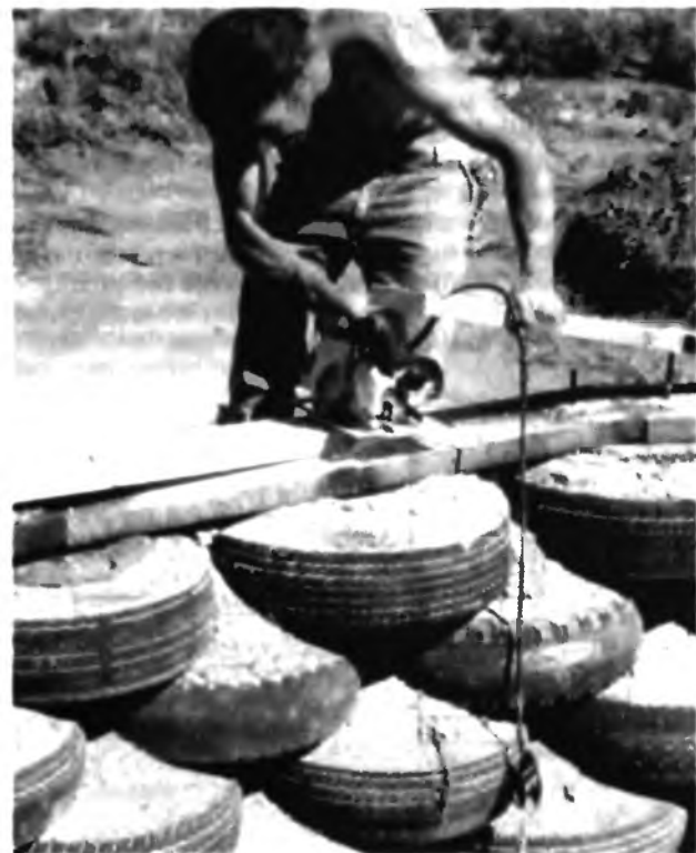
14.2-2, 14.2-3 Стена из использованных автомобильных шин, заполненных грунтом, США
