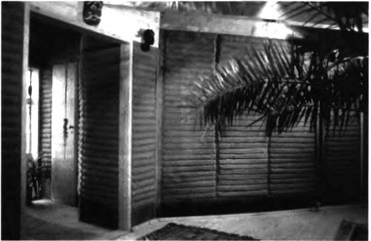
8.4-12 Внутренняя стена из глиносырцовых изделий
