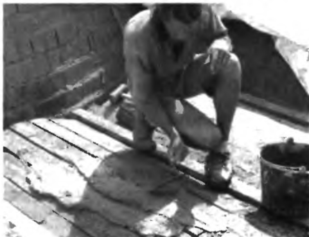
14.7-41, 14.7-42 Возведение цилиндрических сводов с помощью опалубки
